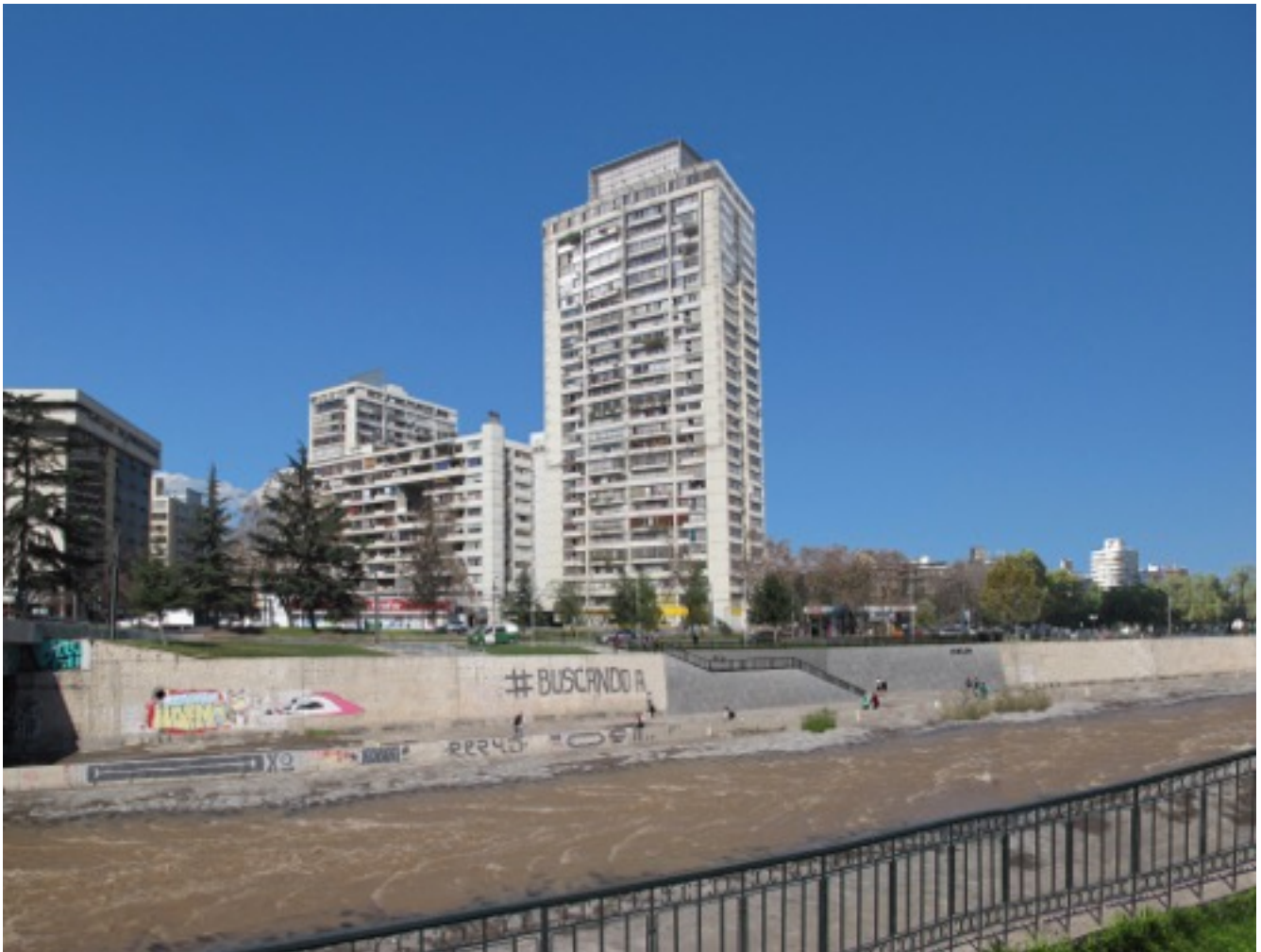
Figura 1.3 Vista desde el norte, Escalera descubierta, Huelén.
