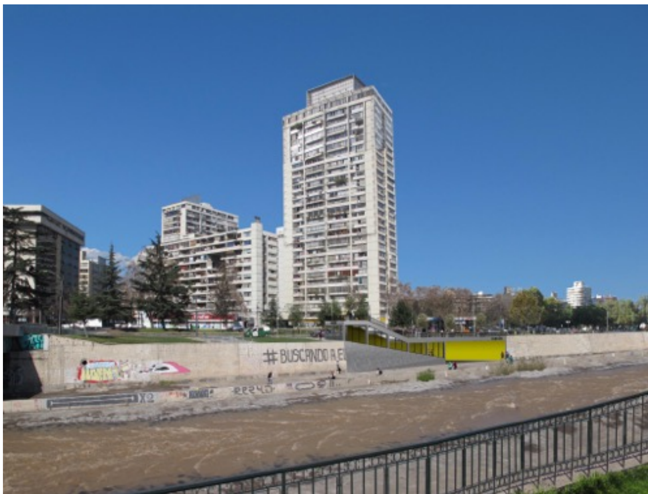
Figura 1.1 Vista desde el norte, Escalera cubierta, Huelén.
